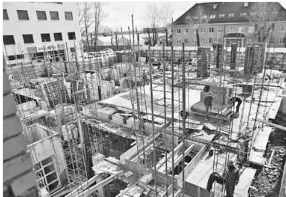
■ Со стороны набережной возводится пристройка сценическо-зрительного комплекса
