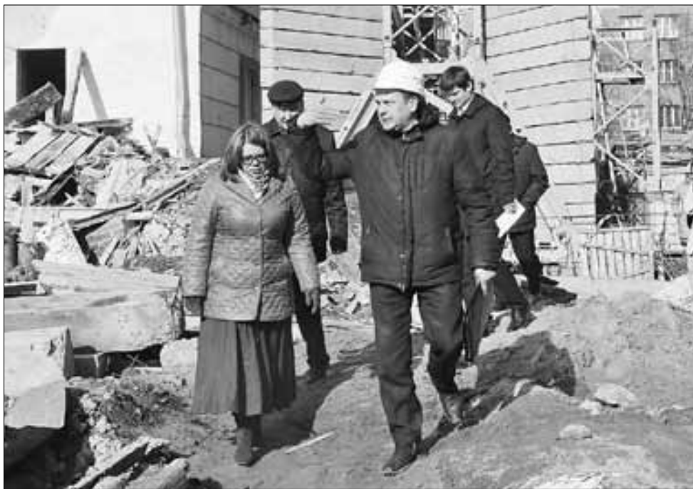
■ Министр культуры Вероника Яничек на объекте строительства
